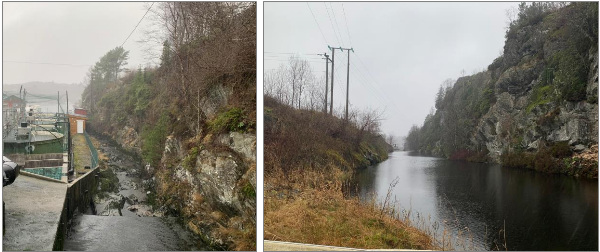
Bilde av nedre del av elva. Til venstre teke frå dagens demning, og til høgre teke frå dagens vassinntak.
